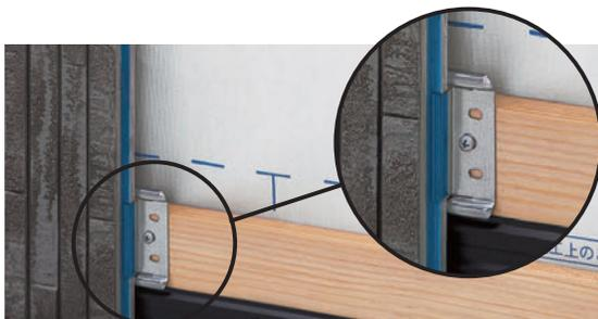
Спец. скобы надежно фиксируют панель на своем месте.
